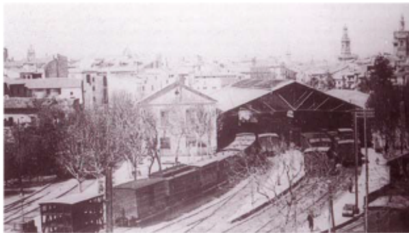
Imatge històrica de l'Estació de València.
