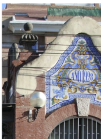
Exemple de clavill en el pedestal derivada de lesions mecàniques en l'element ornamental. Fotografies d'elaboració pròpia.
