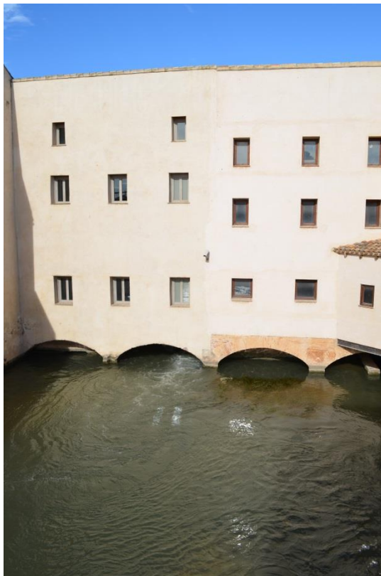
Càrcavos amb voltes semicirculars formant la bassa de sortida. Molí del Testar.
